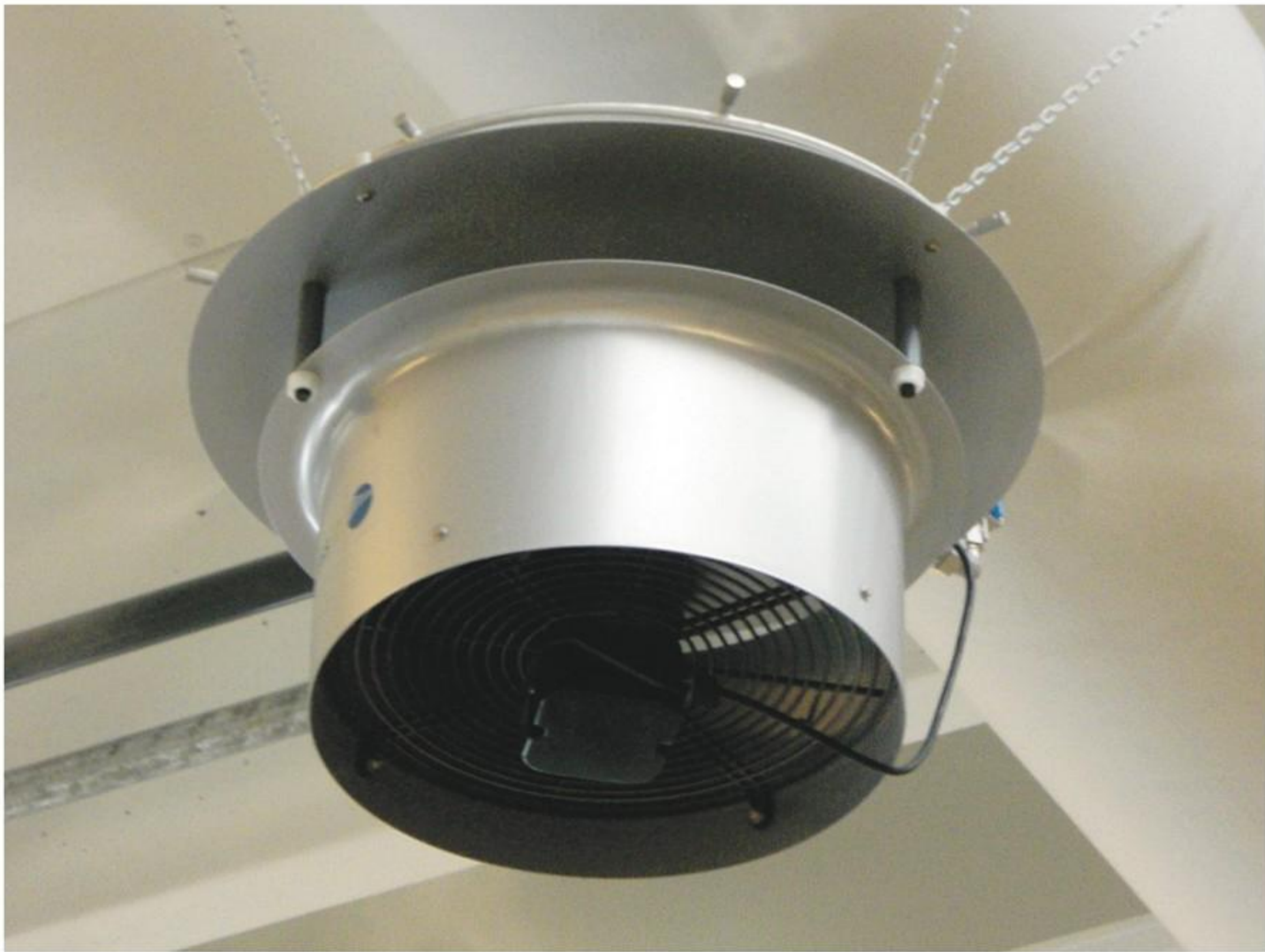
Forstøvningen af det demineraliserede og kulsyre-mættede vand er så fin, at kameraet ikke kan fange det, men de mange loftventilatorer sikrer en luftfugtighed over 45 procent, så man ret effektivt undgår de fleste ESD-problemer.
